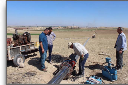
Resim-7,8,9: Boruların kaynak makinesine yerleştirilmesi ve sabitlenmesi
