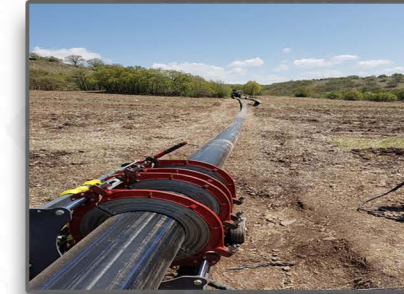
Resim-7,8,9: Boruların kaynak makinesine yerleştirilmesi ve sabitlenmesi
