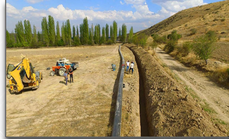
Resim-6: Sahada hızlı bir çalışma için boru kaynak ekibine bir backhoe-loaderin eşlik etmesi .
