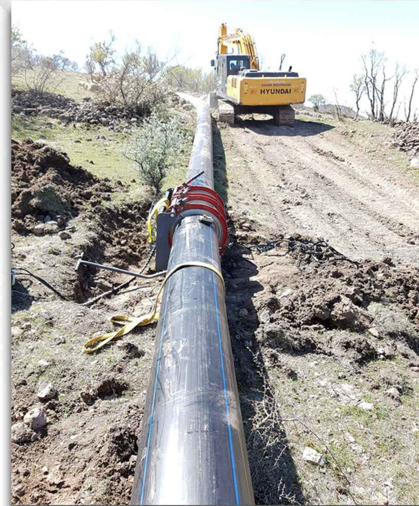
Resim-1: Hendek güzergahına dizilen boruların Alın Kaynağı ile birbirine kaynatılması.
