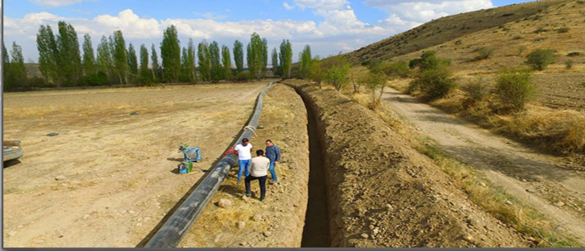
Resim-2: Kazılmış hendek kenarına boru dizilmesi ve kaynatılması
