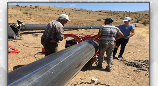
Resim-7,8,9: Boruların kaynak makinesine yerleştirilmesi ve sabitlenmesi
